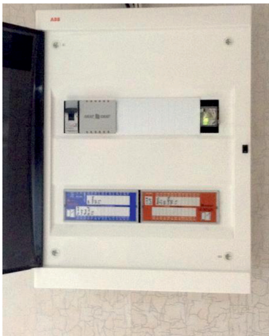
Оснащен модулем SE BPWR, который защищает линии питания 12В в случае возникновения КЗ.
