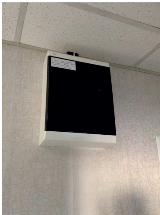
Щит автоматики на базе блока SE 6i50
